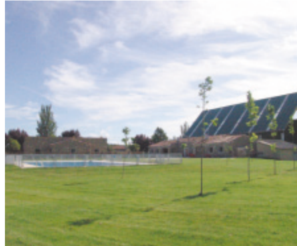
Empleo de placas solares en infraestructuras deportivas.
