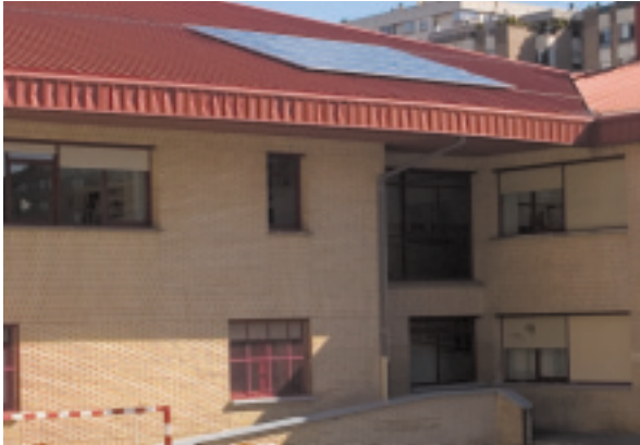
Instalación de placas solares en un colegio público.
